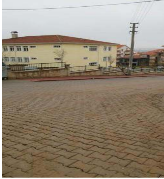
AŞIKPAŞA MAHALLESİ 1987. SOKAK
