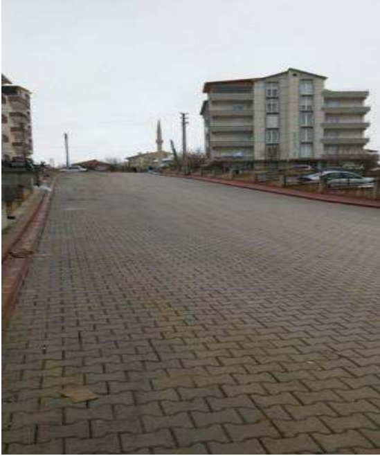
AŞIKPAŞA MAHALLESİ 1992. SOKAK
