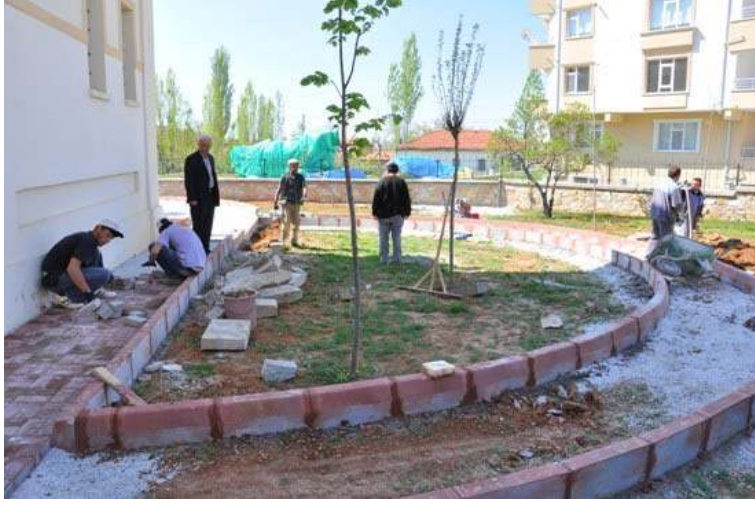
AŞIKPAŞA MAHALLESİ (18. SOKAK)
