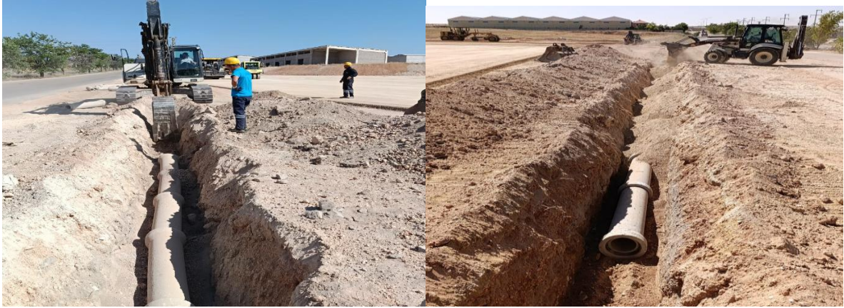
Yağmursuyu Hat Çalışmaları
