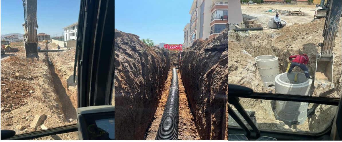
Kanalizasyon Hat Çalışmaları
