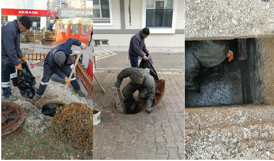
Muayene Bacası, Parsel Bacası ve Mazgal Temizliđi alıřmaları
