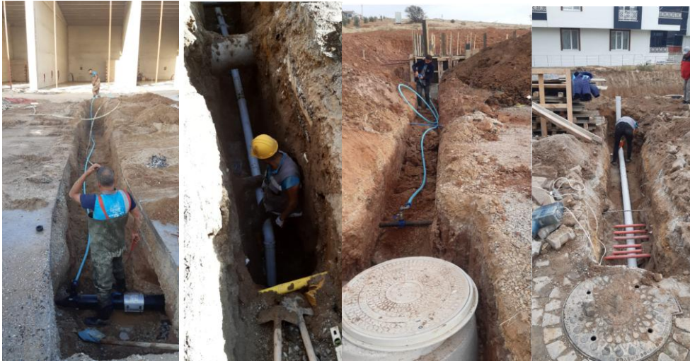
Kanalizasyon Bağlantı Çalışmaları
