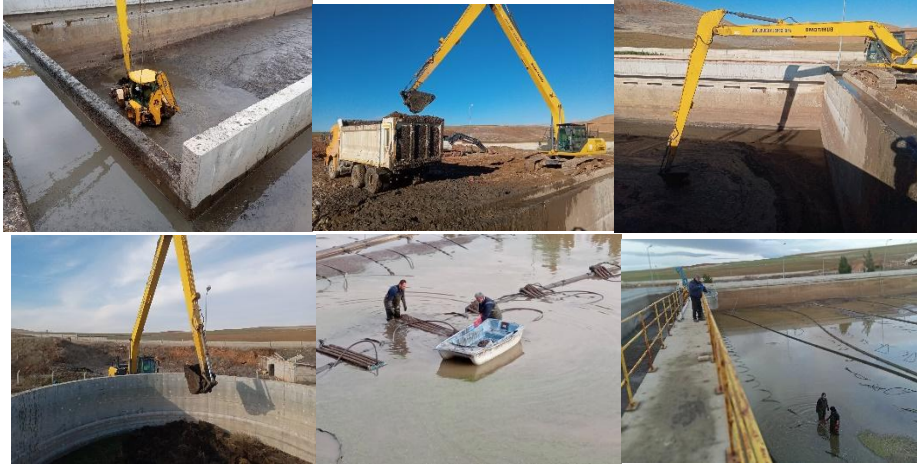
Atıksu Arıtma Tesisi
