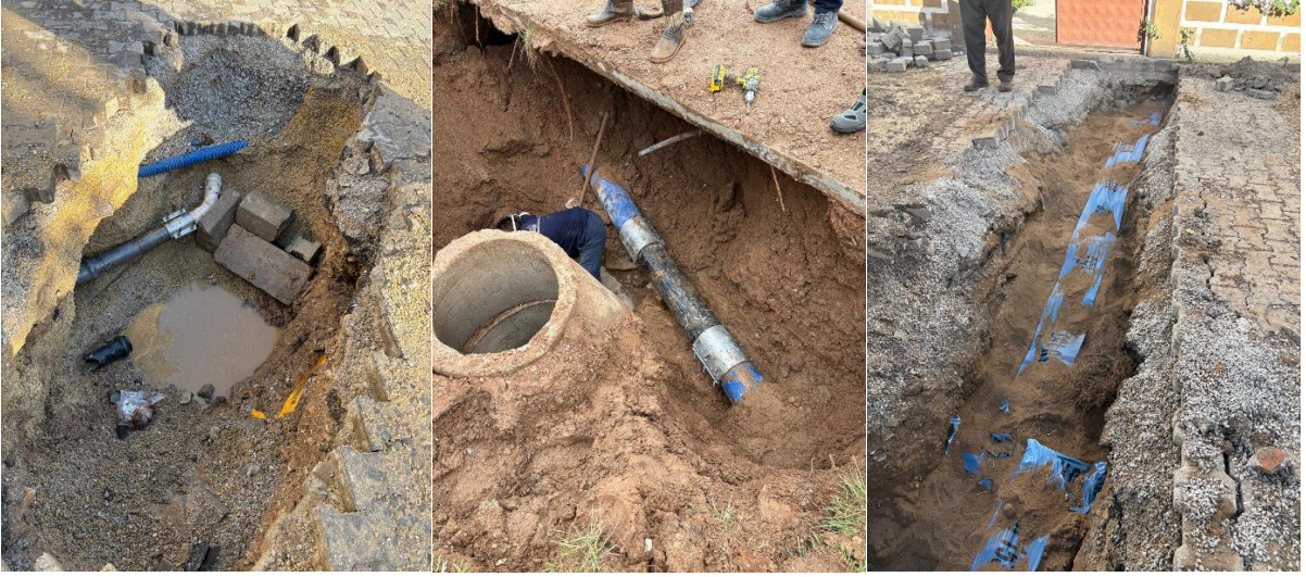
İçme Suyu Hattı Arıza Çalışmaları
