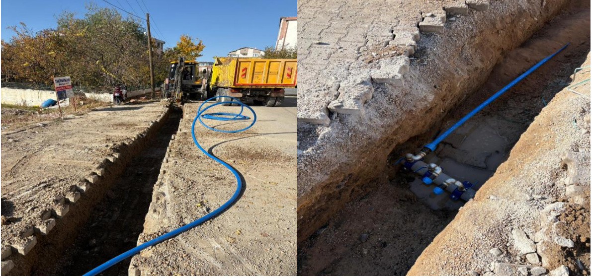
İçme Suyu Abone Bağlantı Çalışmaları
